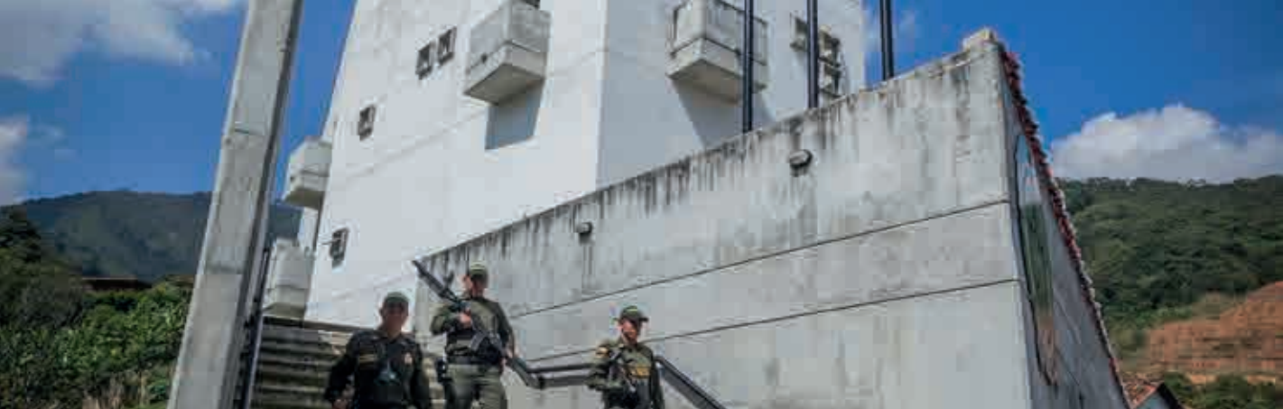
Subestación de Policía Altavista Alcaldía de Medellín
